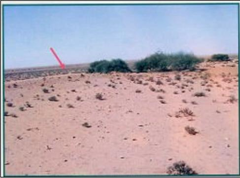
Les architectes de l'ouvrage hydraulique, soucieux de collecter le maximum des eaux de l'oued Zegrir, ont réalisé une Tabia (digue) de déviation au niveau de la Daya de Talemza, à une centaine de kilomètres en amont de G'rara (figure 7). Son rôle est d'éviter l'infiltration de l'eau par un phénomène karstique dans une faille située dans le lit majeur de la rivière.
